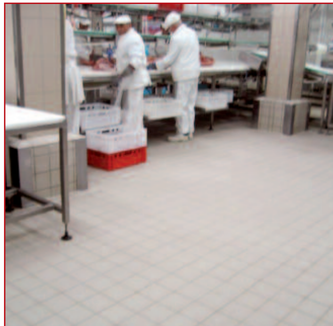
Mesna industrija „PPK“, Karlovac - Klingenberg Sicodur kiselo otporne pločice dim. 150x150x14 mm položene u Granirapid i fugirane Habenitom 60
