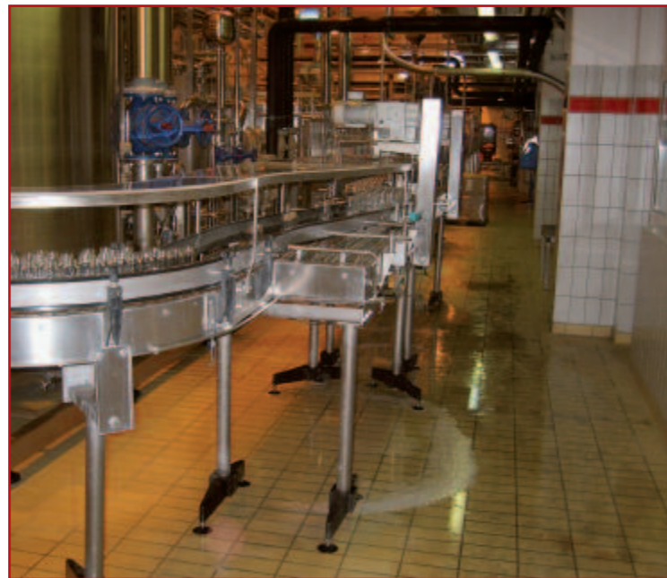
„Coca Cola“ Solin - Höganäs kiselo otporne pločice dim. 215x105x19 mm položene u Granirapid i fugirane Habenitom 60
