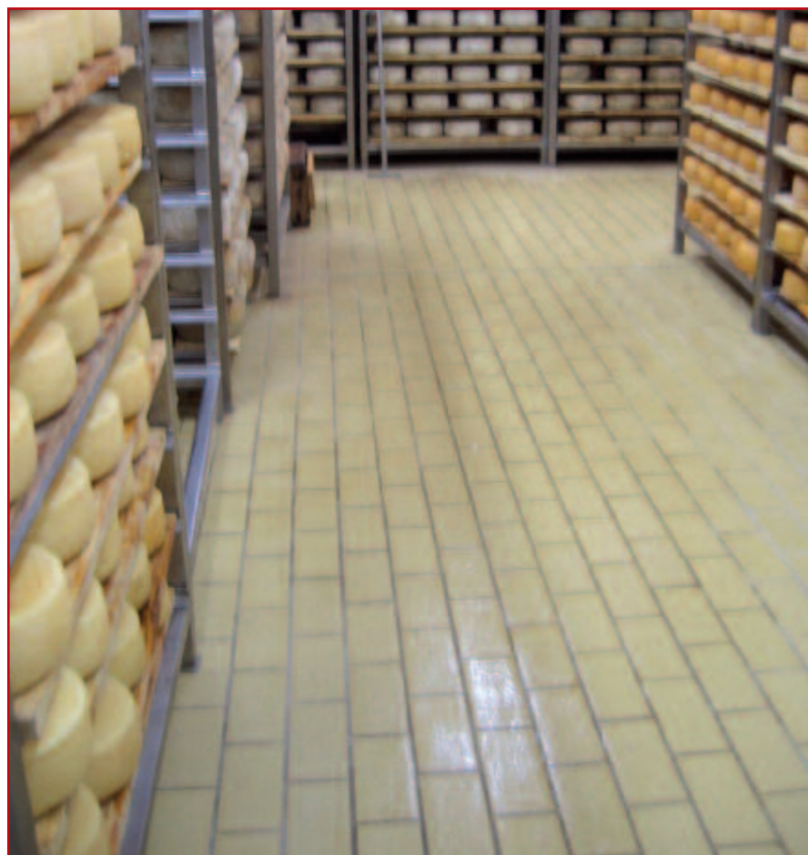
Sirana „Pag“ - Höganäs podne kiselootporne pločice tip 1050 dim. 215x105x19 mm položene u Granirapid i fugirane Habenitom 60
