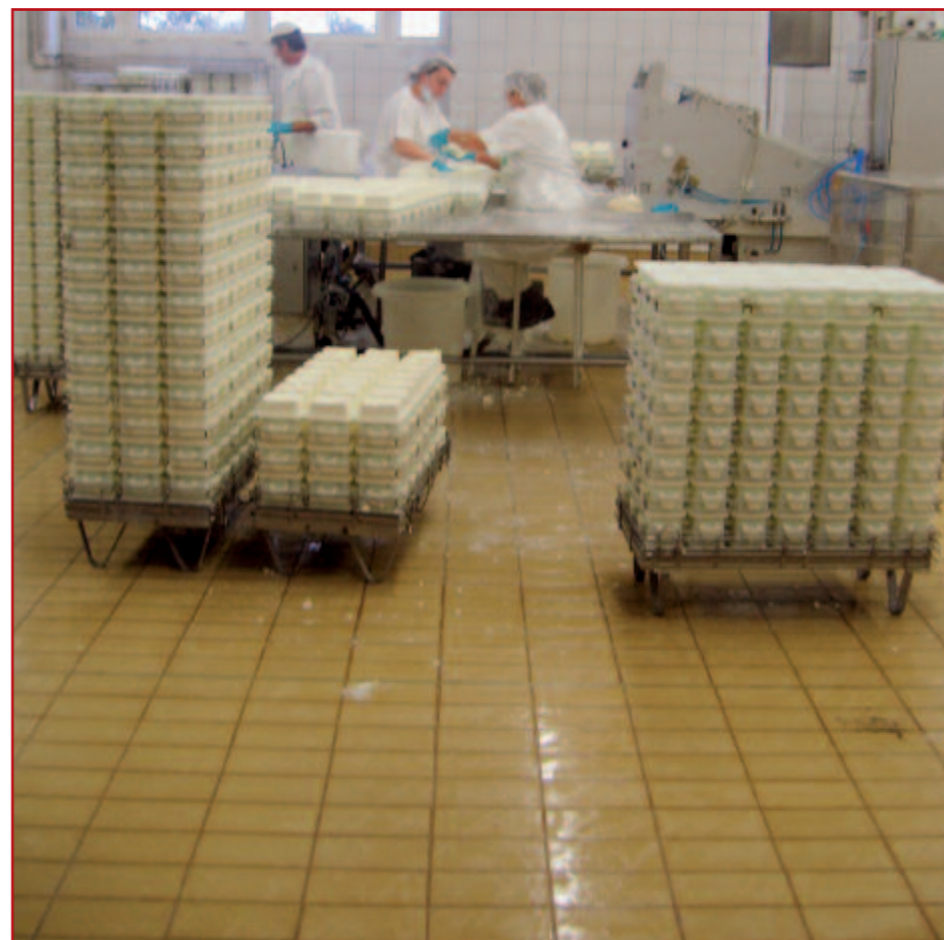
Mliječna industrija „Sirela“, Bjelovar - Interbau Blink kiselootporne podne pločice dim. 240x115x18 mm položene u Granirapid i fugirane Habenitom 60
