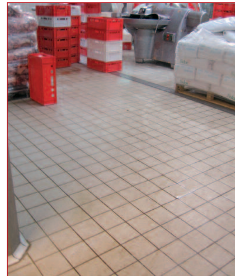
Mesna industrija „Zlatiborac“, Zlatibor - Klingenberg Sicodur kiselootporne pločice dim. 150x150x14 mm položene u Granirapid i fugirane Habenitom 60
