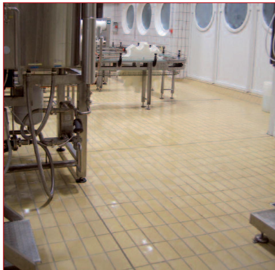
Sirana „Kolan“, Pag - Höganäs kiselootporne pločice tip 1050 dim. 215x105x19 mm položene u Granirapid i fugirane Habenitom 60
