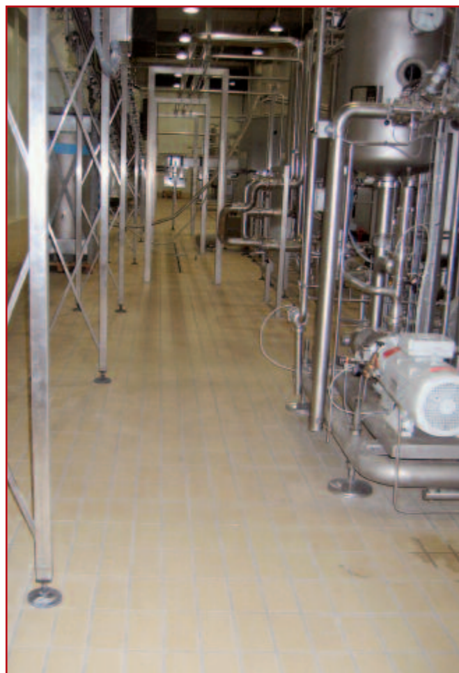
Punionica pića „Jamnica“ - Höganäs kiselo otporne pločice dim. 215x105x19 mm položene u Granirapid i fugirane Habenitom 60
