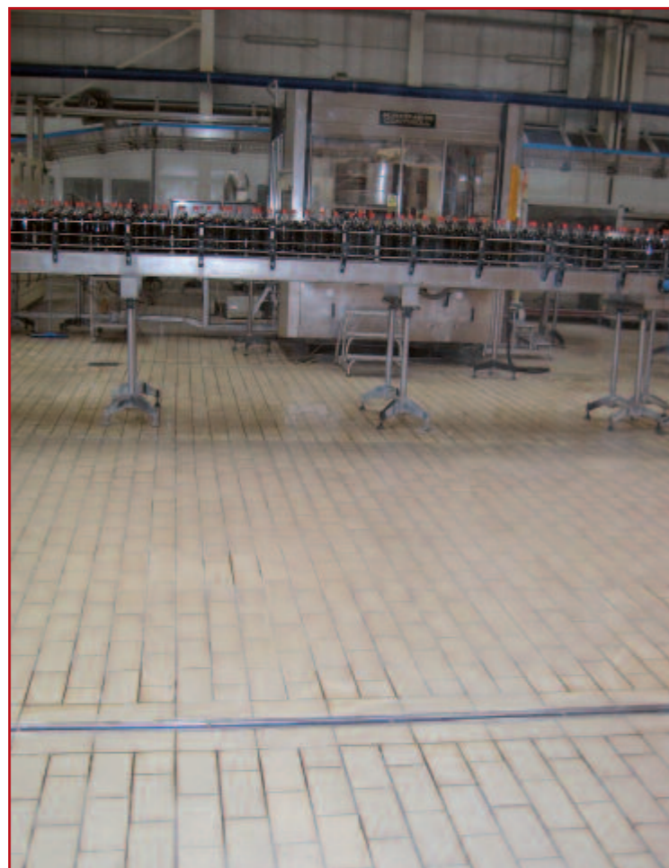
„Coca Cola“ Sarajevo - Gail kiselo otporne pločice dim. 240x115x18 mm položene u Granirapid i fugirane Habenitom 60
