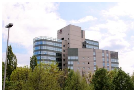
HOTO TOWER Zagreb 5000m 2 BWM podkonstrukcija ATK100+ATK103 sa Keil sidrima, granitne ploče 150x50x2,5cm
