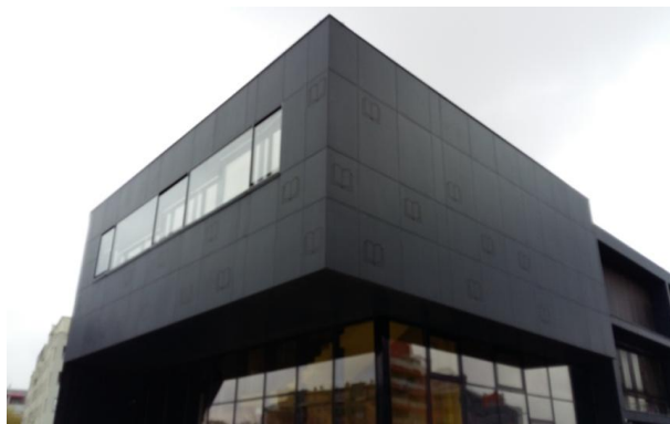
Škola Vrbani – Zagreb, 2.500m 2 BWM potkonstrukcija ATK 100 nitano, aluminijske ploče 3 mm
