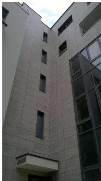
Stambeno poslovni objekt "Galerija Riječka" Rijeka, 1000m 2 BWM potkonstrukcija ATK 100, Keramičke ploče 100x50x1cm
