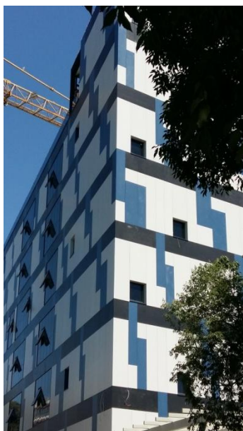
Hotel "Zenta" Split, 2 800m 2 BWM potkonstrukcija ATK 100, SikaTack Keramičke ploče 300x100x0,3 cm
