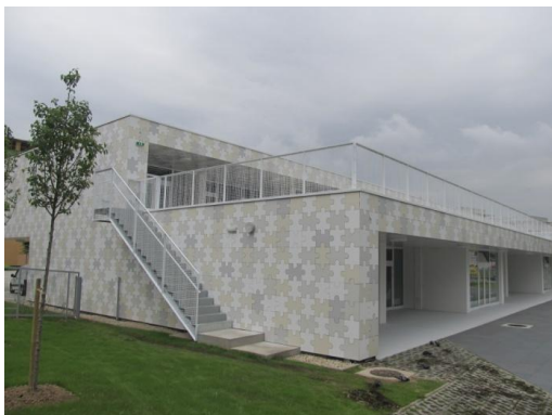
Dječiji vrtić Vrbani – Zagreb, 1500m 2 BWM potkonstrukcija ATK 100- alumini Puzzle, SikaTack Ljepilo
