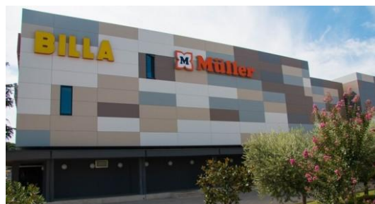
Trgovački centar Riva – Poreč, 3 500m 2 BWM potkonstrukcija ATK 100 SikaTack Keramičke ploče 300x100x0,3 cm
