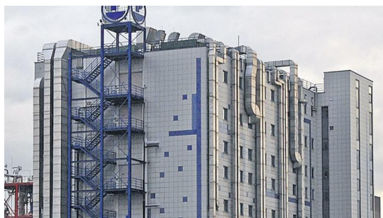
Pliva Azitromicin, izvedeno 1995, 3000m 2 BWM potkonstrukcija ATK 102Minor - keramičke ploče 60x60x1 cm
