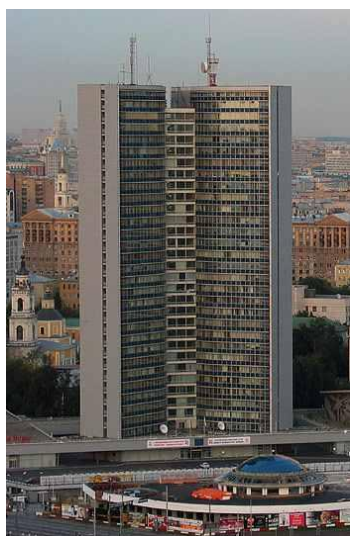
Gradska vijećnica Moskva, Rusija 10 000m 2 BWM potkonstrukcija ATK 102Minor- Keramičke ploče 60x60x1,3 cm
