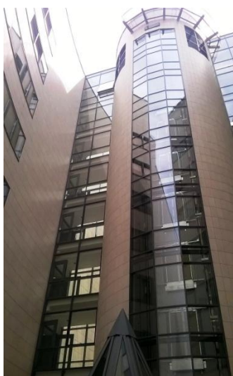
Grand Centar Zagreb, 3000m 2 BWM potkonstrukcija ATK 102 Minor Keramičke ploče 60x60x1 cm
