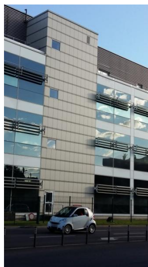
Pliva Institut Zagreb, 1200m 2 , BWM potkonstrukcija ATK 102Minor, keramičke ploče 90x60x1 cm
